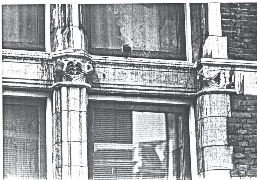
36. (boven) Idem 33, détail gevel aan de Vismarkt. (MD)
